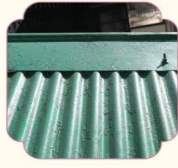
MAINTENANCE OF ROOFTOPS छतों का रखरखाव
